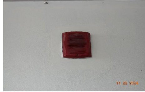
กริ่งสัญญาณเตือนภัย
